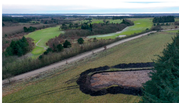
ARV 474 Hennebysvej, dronefoto. I forgrunden det afgravede søområde. I baggrunden skimtes Filso.
