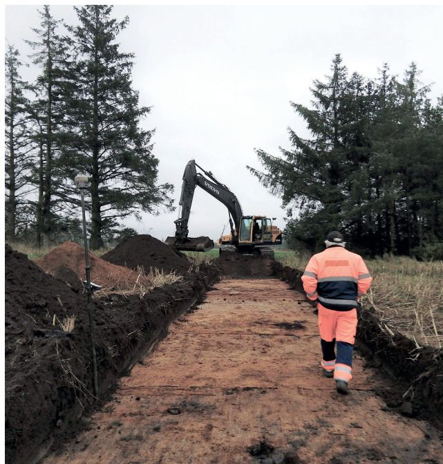
Henning går mod gravemaskinen efter at have gravet grøften til ende – nu skal han dække den til igen.
