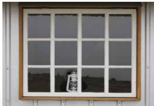
Oprindeligt vindue i beboelseshus efter istandsættelse: Den tophængte vinduesramme er istandsat. Underkarmen har fået ny falsnakke af eg, og inddækningen af hhv. overkarm og sidekarme er udført med eg. Foto: Steffen M. Søndergaard, jan. 2019.
