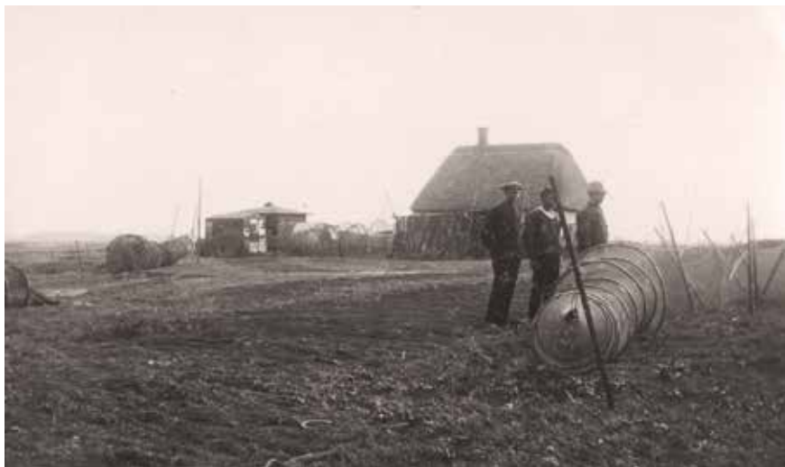
En af de ældste fotooptagelser af Provstgaards Hus – eller snarere huse – for ud over det strå-tækte beboelseshus og "den pæne stue" med det tagpapdækkede pyramidetag ses også et skur foran sidstnævnte. Beboelseshuset ses her i den oprindelige, kortere udgave med kun én skorsten, og på "den pæne stue" ses, at den lille pyramide, der kroner selve taget, er åbnet og derfor må være en sidehængt ventilationslem.
