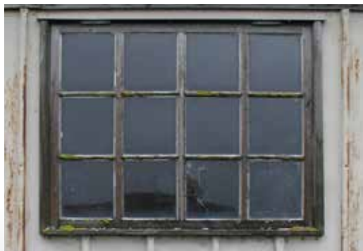
Oprindeligt vindue i beboelseshus. Foto: Steffen M. Søndergaard, nov. 2012.
