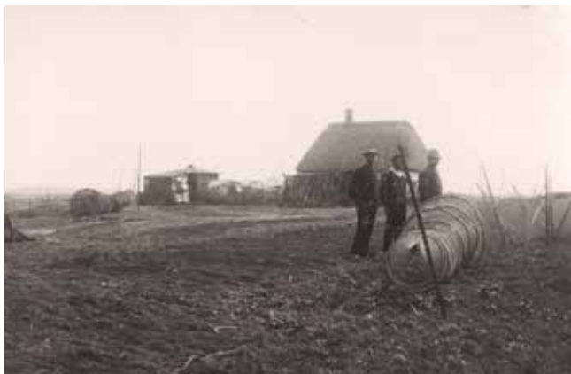
Provstgaards Hus før første ombygning, bemærk der kun er én skorsten.
