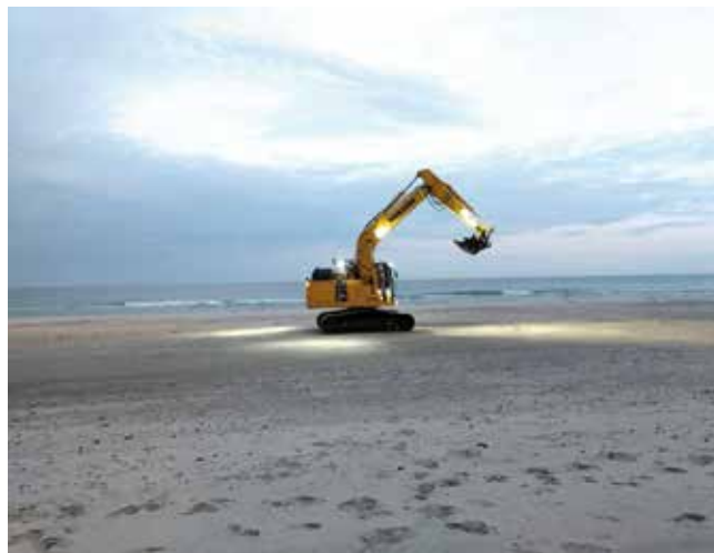
ARV 3 VF. Det er ikke så tit man ser en gravemaskine på stranden, men det var nødvendigt i forbindelse med undersøgelserne ved ilandføringen af elkablet fra havvindmøllerne.
