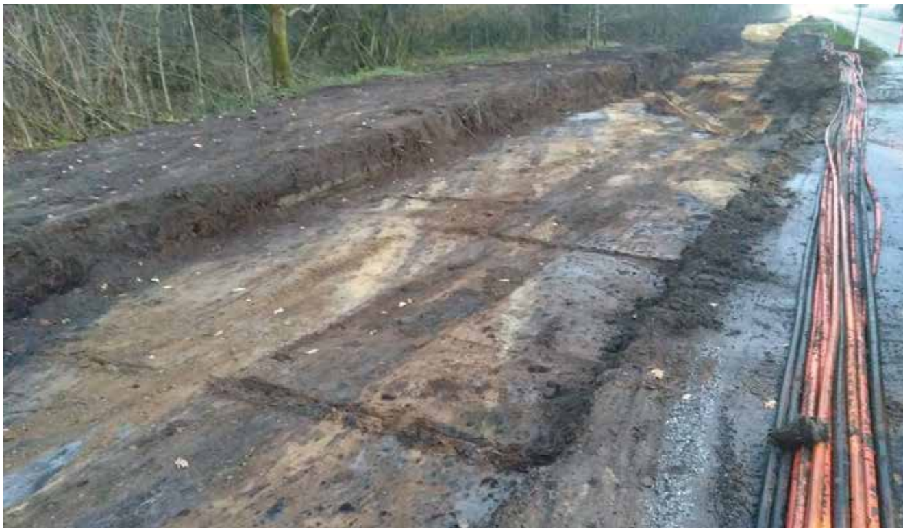
ARV 219. Den gamle landevej mellem Tarm og Nørre Nebel. Vejbanen med pløjespor fra etableringen ses sammen med den ene vejgrøft, der nu er tømt.
