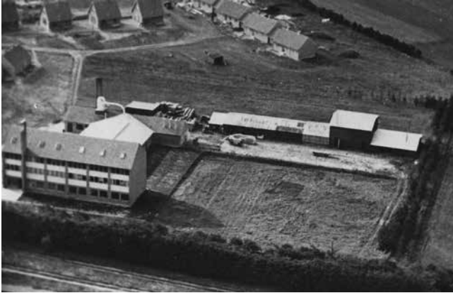
Foto fra ca. 1947, hvor man er gået i gang med at genopbygge fabrikken.
