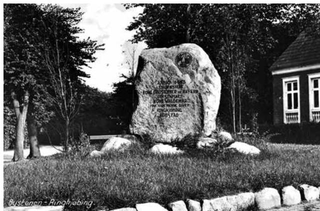
I dag er både den pyntelige forhøjning og jernbanehotellet i baggrunden væk. Men se selv efter ved Østergades udmunding i Nørredige. Bysten er der endnu.
