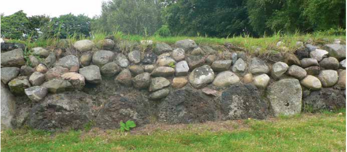
Kirkegårdsdiget ved Tistrup kirke er delvist bygget af slagge fra huller under jernudvindingsovne. Det er tydeligt, at hullerne har haft en diameter på mellem 40 og 60 cm og på nogle af slaggerne er der meget tydelige aftryk af spadestik, der er 11 cm og 9 cm brede. Foto: Henriette Lyngstrøm.
