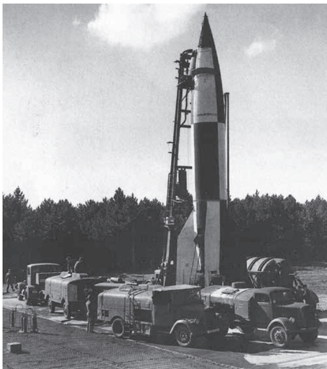
En af de tre V-2-raketter, der blev affyret fra Cuxhaven af briterne. I Operation Backfire blev V-2'eren malet i store skaktern for at man kunne foretage mere præcise målinger af den under affyringen. Fotografi taget under operationen. 30
