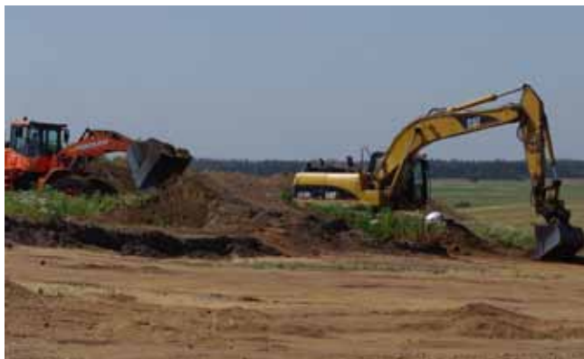
Pløjegjorden afrømmes med maskine for at blottlægge sporene efter husene. I baggrunden ses de lavtliggende brede enge.
