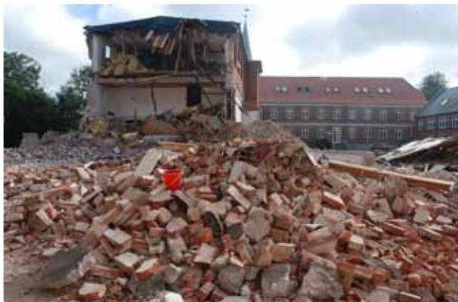
Ombygning, nybygning, nedrivning og udgravning foregik gennem hele udgravningen sideløbende. Mens vi gravede på den sydlige del af grunden, var de store maskiner i gang i den øvre skolegård.
