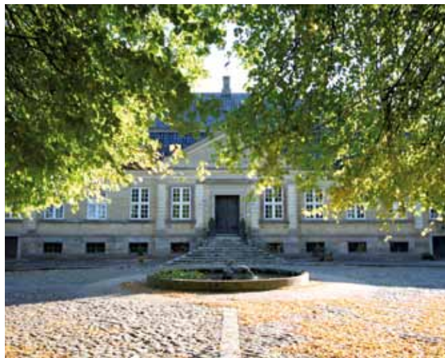
Nørholm ved Varde. Foto: Tonni Storm Nikolajsen.
