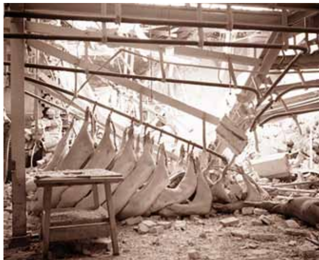
Skaderne indenfor i slagteriet efter bombningen. Svinene hang klar til partering; nu er de klar til destruktions.
