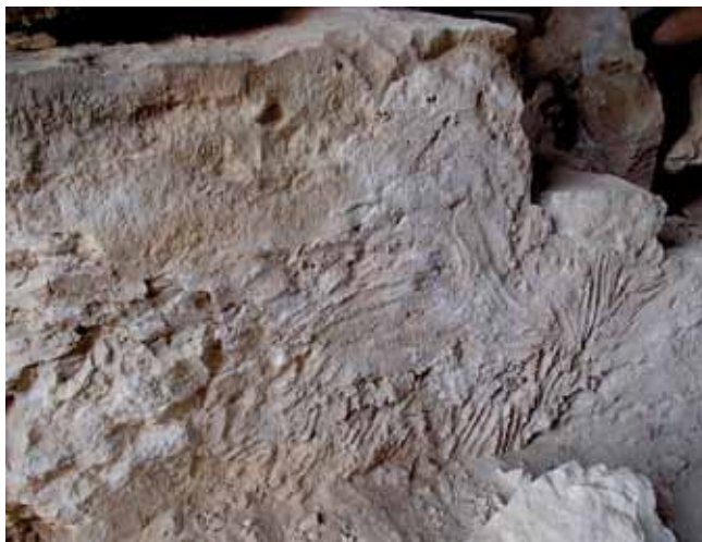
Fingeraftryk i mørtlen på murværket ved indgangen til gravkammeret. Det er fra denne mørtel, det er muligt at udtage C14-prøver, idet der er små stykker trækul indlejret i den.
