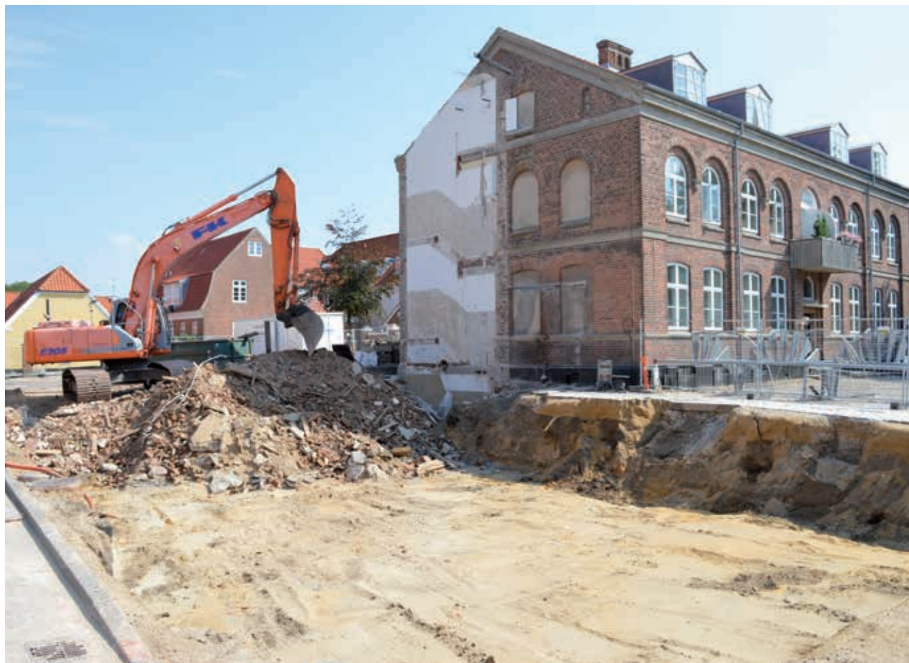
Den gamle Borger- og Realskole og dens kælder er fjernet og den intakte undergrund under kælderniveau ses afrenset.
