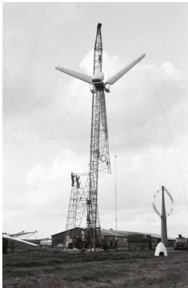
En Vestasmølle, med HVK-designet, er ved at blive rejst ved Vestas' fabrik i Lem. Ved siden af står den lodretakslede mølle. Man forstår godt den bliver kaldt “piskeriset”.
