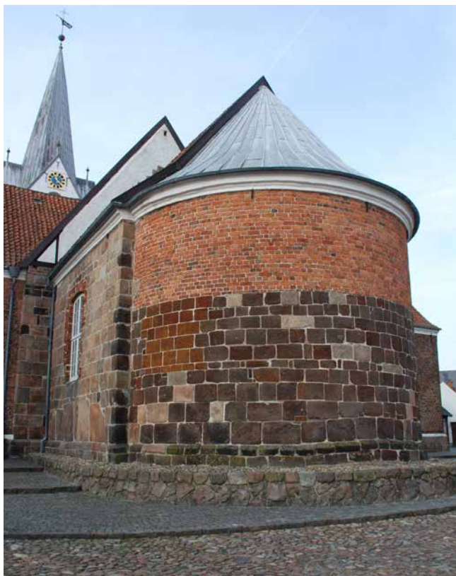
Den øverste tredjedel af S. Jacobi Kirkes apsis er muret i tegl, som en synlig påmindelse om den store brand i 1551. At det er den øverste del, der er udskiftet, viser, at branden også her havde fat i tagværket.
