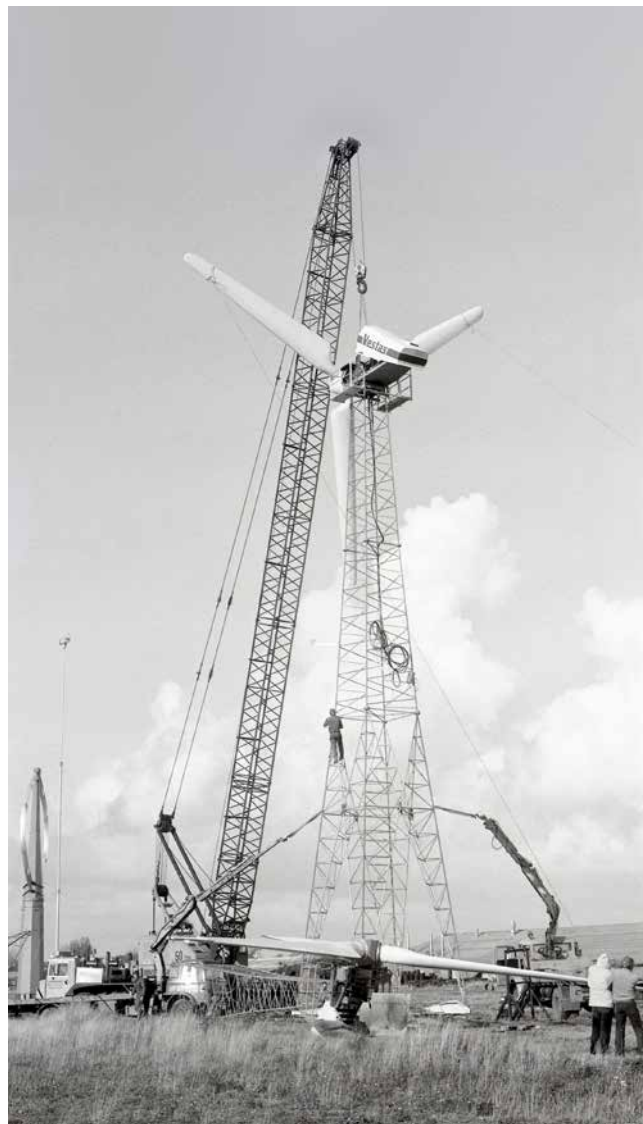
Trevinget vindmølle bygget hos Vestas i Lem. Bemærk vindmøllen til venstre i bunden af billedet. Det forvoksede piskeris var Vestas første prototype på en vindmølle. 11
