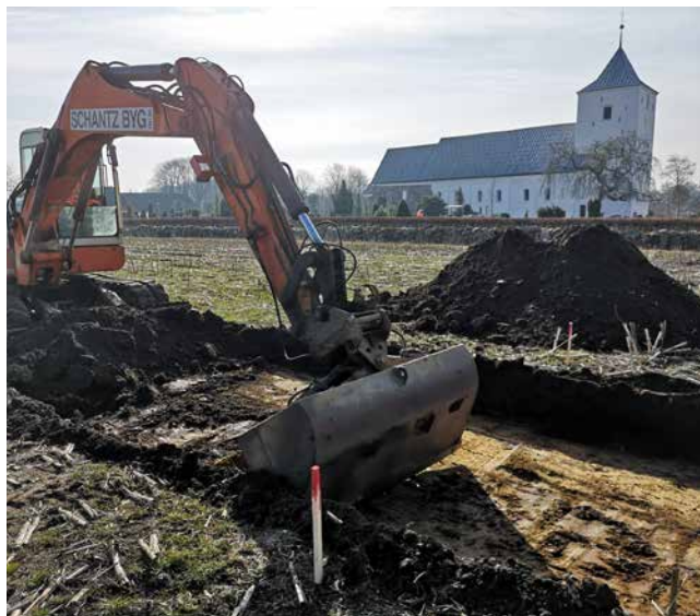
ARV 508. Afgravning af cykelstitracé – Outrup kirke i baggrunden.
