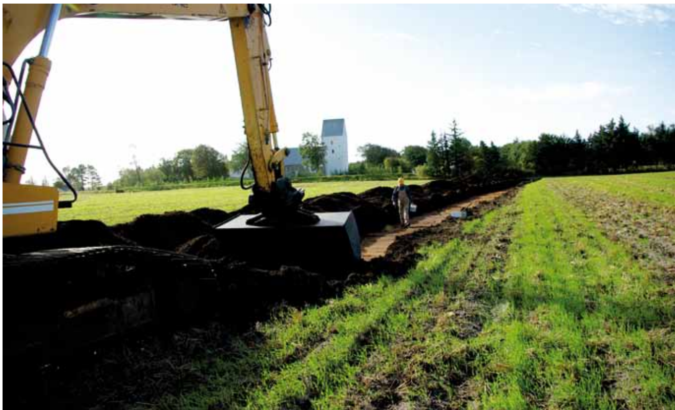
Udgravningen ved Henne. Varde Maskinstation har lige købt en ny 3 m bred skovl til deres gravemaskine, hvilket effektiviserer gravningen af søgegrøfter betydeligt.
